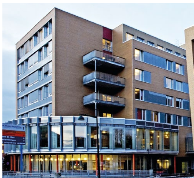
Øya helsehus er lokalisert som nærmeste nabo til St. Olavs hospital, med broforbindelse mellom sykehuset og helsehuset. Foto: Vibeke Leistad.
