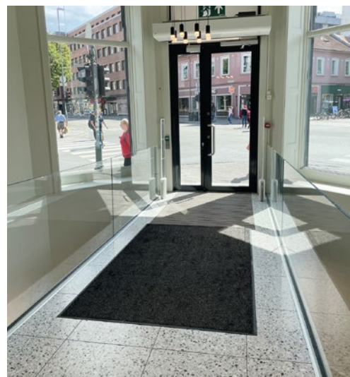
Denne butikken har laget en innvendig rampe som sørger for en trinnfri adgang fra gaten.
