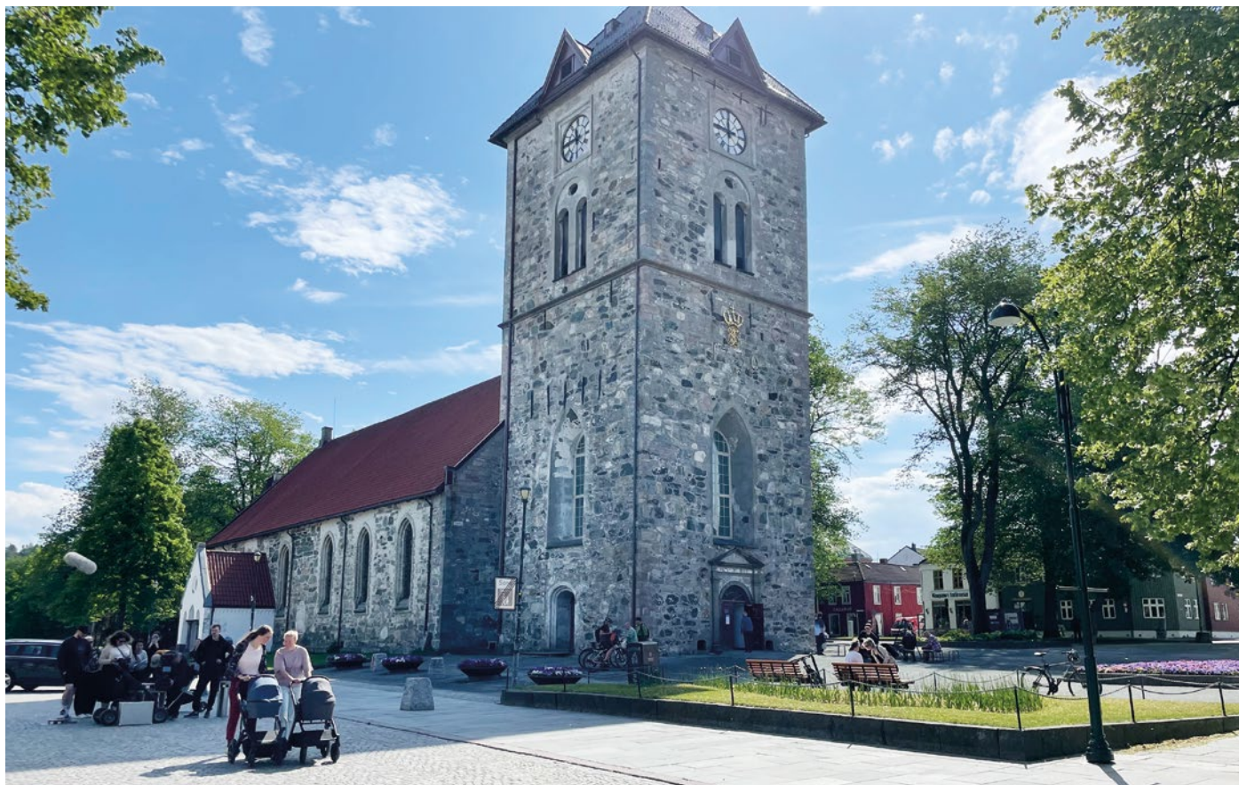
Rundt Vår Frue kirke var det en nivåforskjell på 30 centimeter. Her ble høydeforskjellen utjevnet over størst mulig areal, og kirken fikk trinnfri adgang.
